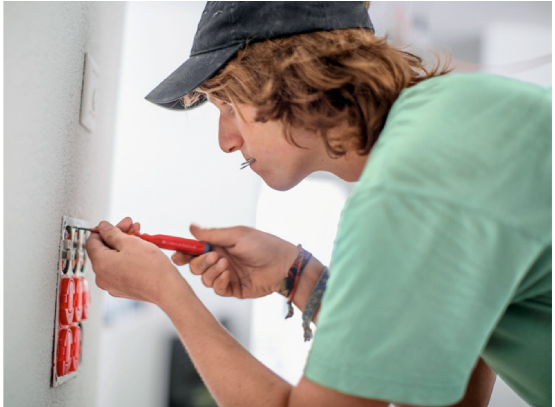
Ein Elektrikerlehrling installiert einen Lichtschalter in einem Neubau.
